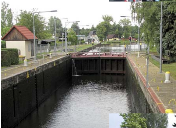
Die Zugbrücke in Zehdenick mit der stromauf dahinterliegenden Schleuse
