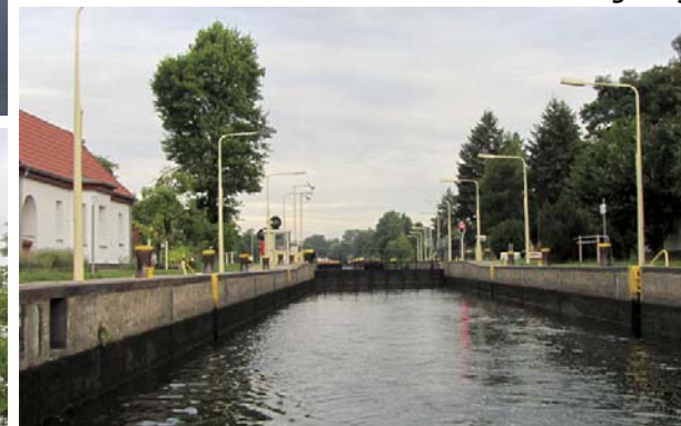
Blick in die Schleuse Plötzensee, der Hub ist hier sehr gering
