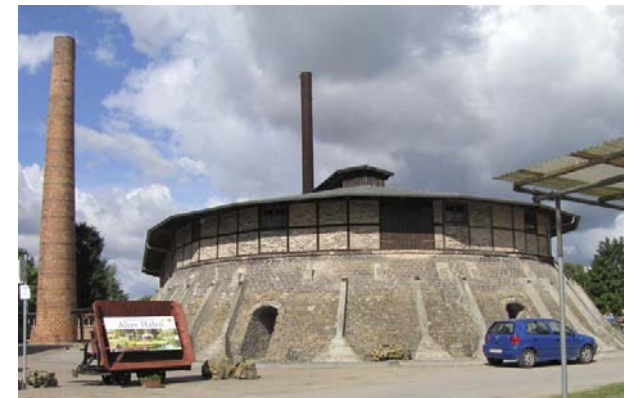
Hoffmannscher Ringofen, 1894 gebaut, bis 1990 wurde hier produziert Im Ringofen, mit einem Ziegel durchläuft man den Ofen, die Farbe ändert sich mit der damals hier herrschenden Temperatur, wird bis tiefrot und zum Ender des Ofens wieder weiß
