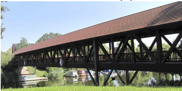
Pionierbrücke, Fachwerkkonstruktion, für Fußgänger und Radfahrer
