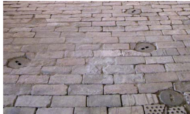
Schüttlöcher, hier wurde der Brennvorgang beobachtet und Brennstoff aufgefüllt
