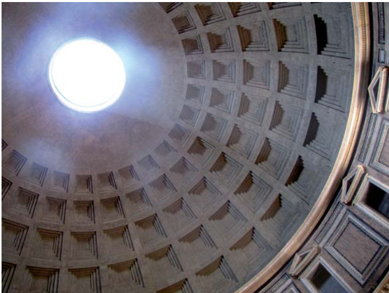
Die Kuppelöffnung hat einen Durchmesser von 9 m und ist offen, zudem, neben der Eingangstür, die einzige Lichtquelle
