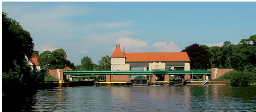
Hinter der Schleuse Klein Machnow, stromab
