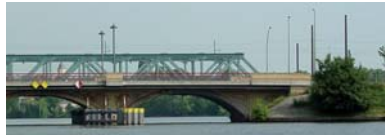
Lange Brücke, Dahme
