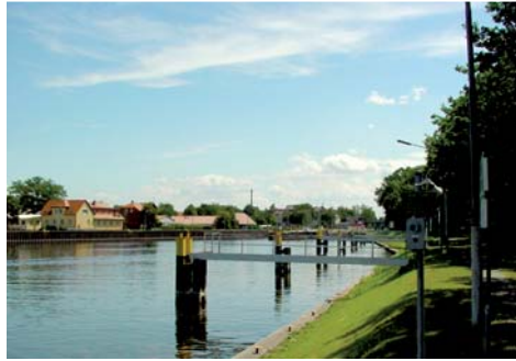
Der Schleusen Anleger an der Brandenburger Vorstadtschleuse
