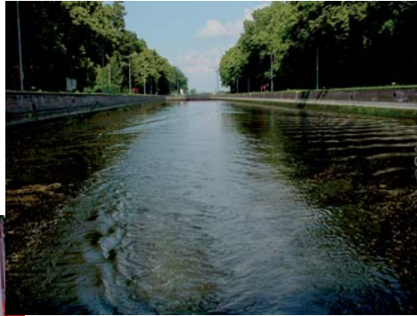
In der Schleuse Bahnitz
