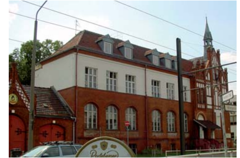
Unter Denkmalschutz stehende Wagenhalle der Straßenbahn, Schmöckwitz
