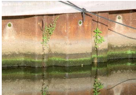
Sinkender Wasserstand im Hafenbecken bei der Vorbeifahrt von einem Schubverband
