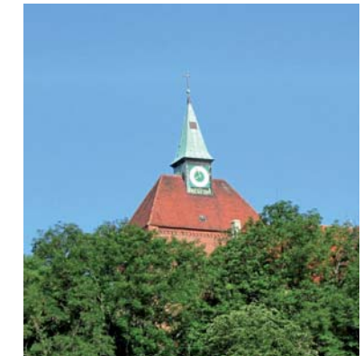
Blick aus dem Elbtal auf die Kirche St. Georg
