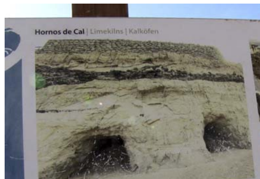
Das Besondere an diesen Öfen ist, dass sie in den Fels gehauen wurden (zur Besichtigung folgen Sie bitte dem Wanderweg). Durch das im Ofen angezündete Feuer wird der Kalkstein zu Branntkalk verarbeitet. Dieser wird von den Anlegern aus verschifft.
