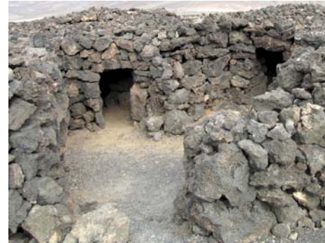
Durch aneinanderlegen von länglichen Steinplatten entstand ein Kuppeldach
