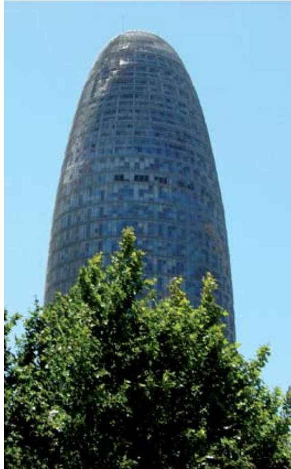
Torre Agbar, Bürogebäude an der Avenida Diagonal, mit 142 m zählt er mit zu den höchsten Gebäuden Kataloniens, geplant vom Architekten Jean Nouvel, der Überlegungen Gaudis mit einbezog, gebaut aus Beton mit Glas-Aluminium-Fassade, eingeweiht 2005
