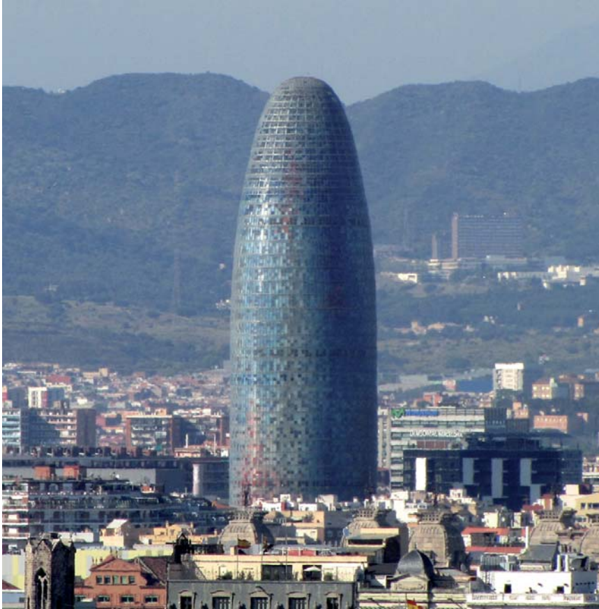
Torre Agbar, Bürogebäude an der Avenida Diagonal, mit 142 m zählt er mit zu den höchsten Gebäuden Kataloniens, geplant vom Architekten Jean Nouvel, der Überlegungen Gaudis mit einbezog, gebaut aus Beton mit Glas-Aluminium-Fassade, eingeweiht 2005
